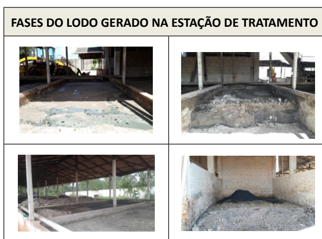
Figura 27 - Estágios de transformação do lodo em adubo.
