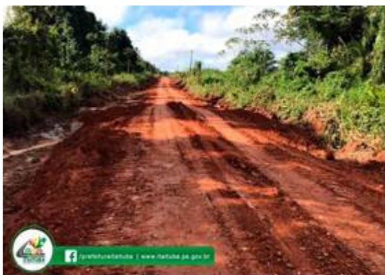
Figura 2. Estrada de acesso à comunidade Pedra Branca.
