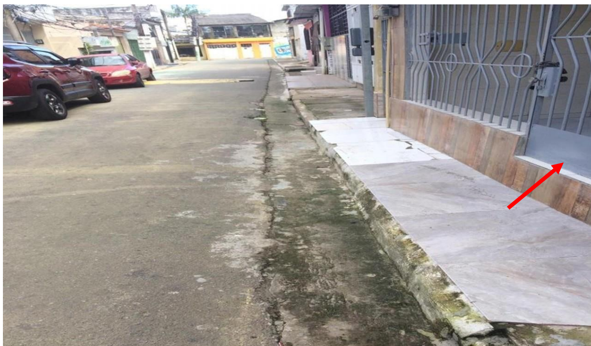
Figura 6. Confecção de barreira de contenção da água (seta vermelha).
