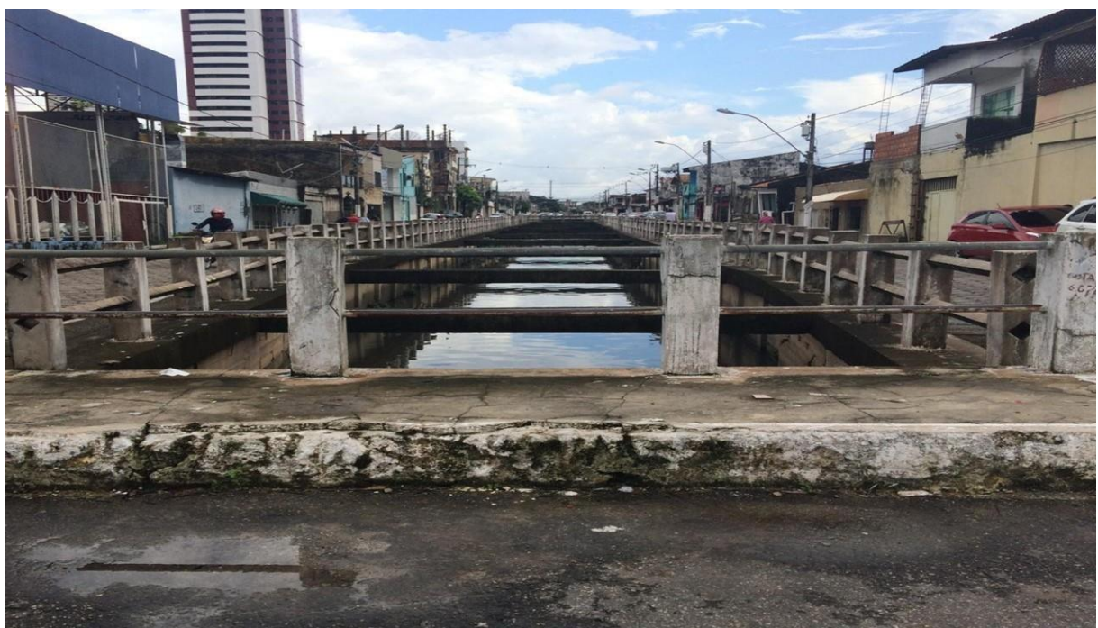
Figura 1. Canal da 14 de março, entre a Avenida Conselheiro Furtado e a Rua dos Mundurucus.
