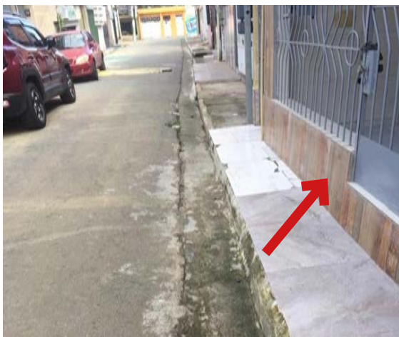
Figura 6. Confeção de barreira de contenção da água (seta vermelha).
