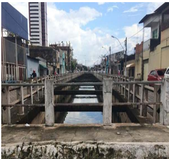
Figura 1. Canal da 14 de março, entre a Avenida Conselheiro Furtado e a Rua dos Mundurucus.
