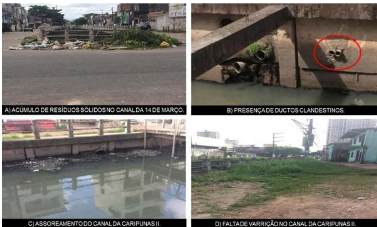
Figura 5. Canais de macrodrenagem.
