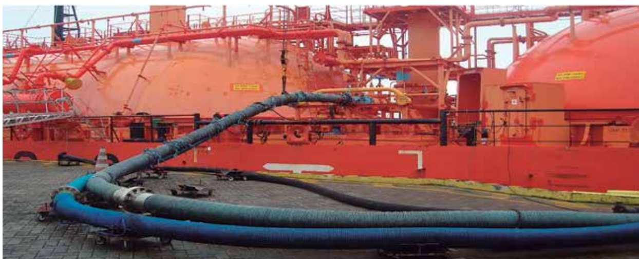
Figura 05. Inspeção no mangote.
