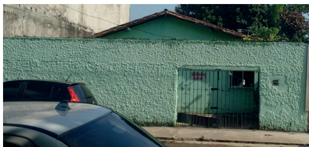
Figura 3: Cacos de vidro sobre o muro.
