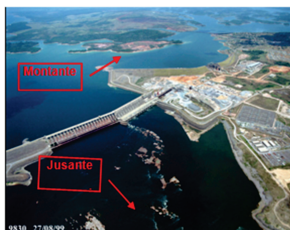
Figura 1. Montante e jusante da UHE Tucuruí. Fonte: Eletronorte (1999).
