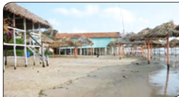
Figuras 15. Evidências de erosão no setor costeiro sul da praia do Pesqueiro (Braga, 2007).
