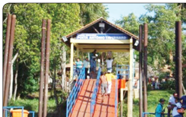
Figura 9. Rampa de acesso a Ilha.
