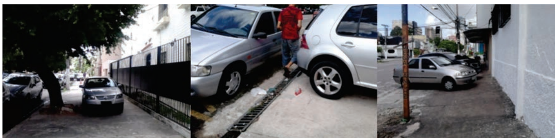
Figura 6 - Veículos dificultando o deslocamento e ausência de piso tátil.
