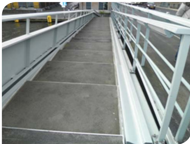
Figura 8. Escada com calhas para a circulação de bicicletas em Amsterdã - Holanda.
