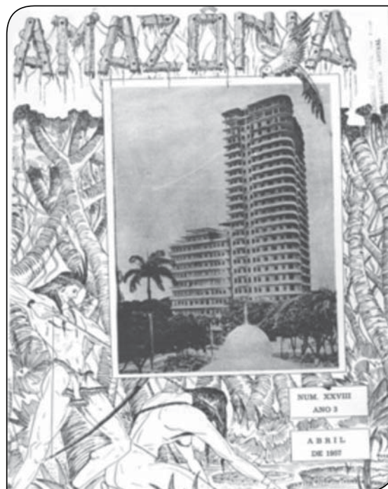
Figura 7. Rev Amazônia - 1957: O edifício em fase de finalização.
