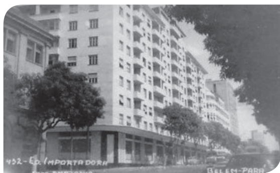
Figura 6. Cartão postal do edifício “Importadora” – Década de 1950.
