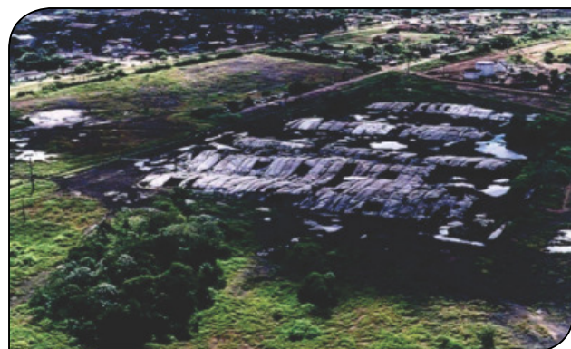
Figura 2 – Deposição indevida de rejeitos (OBSERVATÓRIO SOCIAL, 2003).
