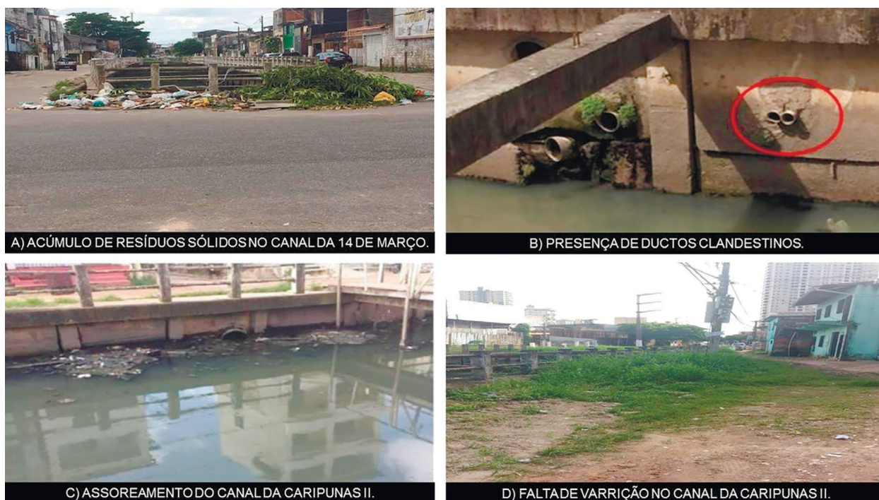
Figura 5. Canais de macrodrenagem.
